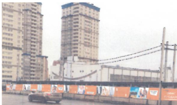
461 (Н) Московская область, г. Пушкино, ст. Ярославское ш., вблизи д.185, реклама на строительном ограждении (без подсвета), присоединенная, 42,13*1,2м, сторона А
