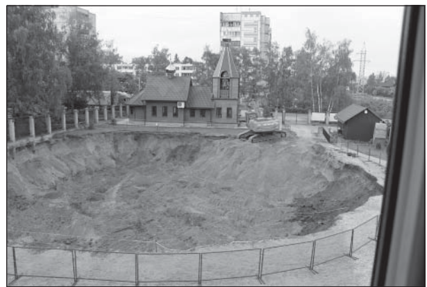
Начало строительства нового здания Храма иконы Божьей Матери "Неупиваемая чаша"
