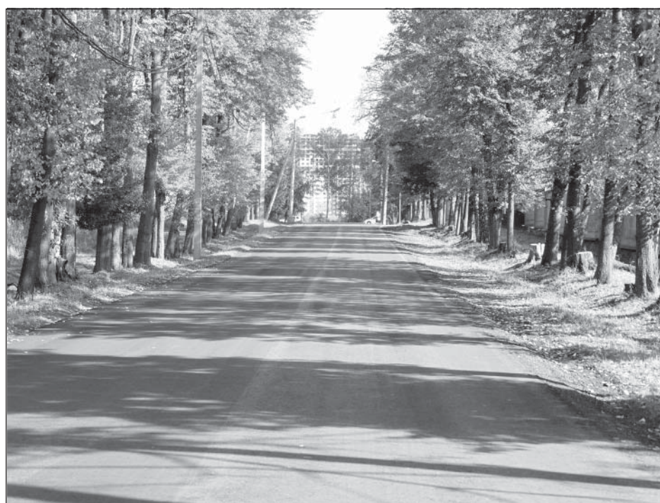
... и после ремонта
